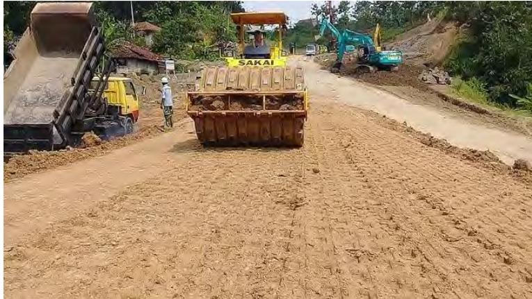
Gambar 6. Pemadatan dengan roller getar
