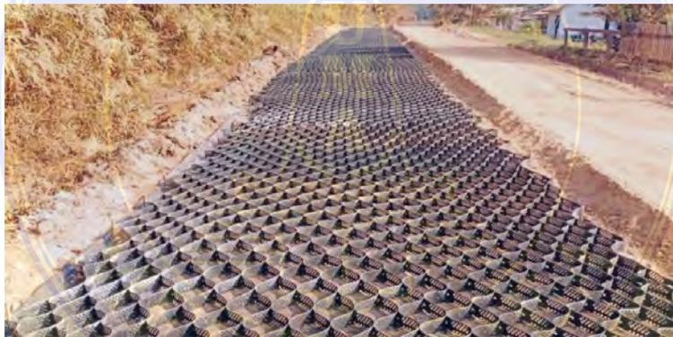
Gambar 4. Lapisan geocell tersebar di seluruh ruas jalan
