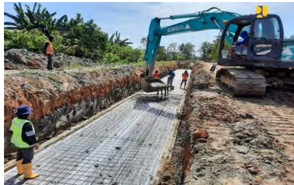
Gambar 2. Pembangunan dan rehabilitasi jaringan irigasi Baliase
