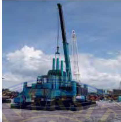
Gambar 3. 4 Hidrolik Jack In Pile Sumber : Data Lapangan
