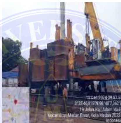
Gambar 4.6 Pemancangan Tiang Pancang Sumber : Data Lapangan
