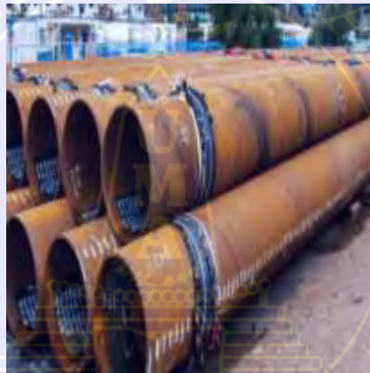
Gambar 4.2 Tiang Pancang Baja Sumber : Data Lapangan
