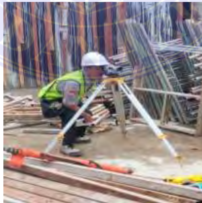
Gambar 3. 3 Waterpass Sumber : Data Lapangan
