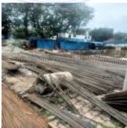
Gambar 3. 16 Baja Tulangan Sumber : Data Lapangan
