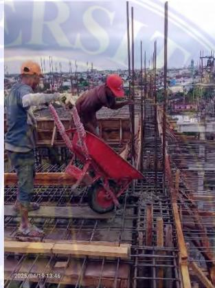
Gambar 4.3. Pengecoran Kolom (Data Lapangan, 2025)
