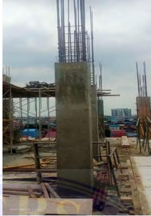
Gambar 4.4. Pelepasan Bekisting Kolom (Data Lapangan, 2025)
