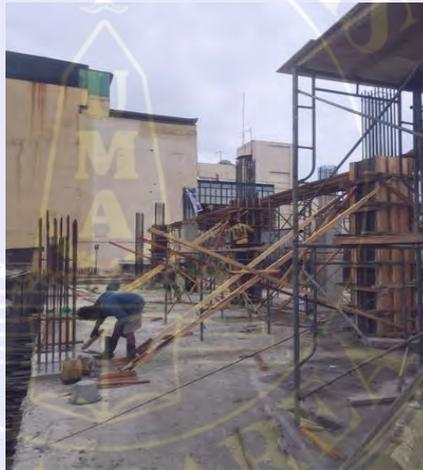
Gambar 4.2. Pemasangan Bekisting Kolom (Data Lapangan, 2025)
