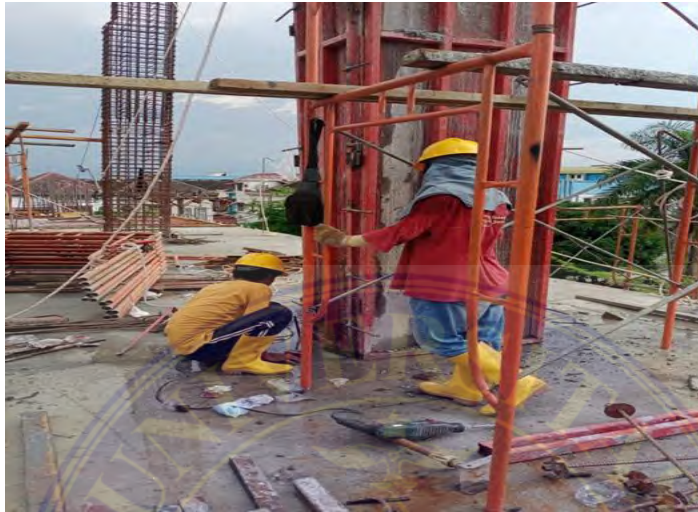
Gambar 4. 1 Pemasangan Bekisting (Dokumentasi Proyek 2024)
