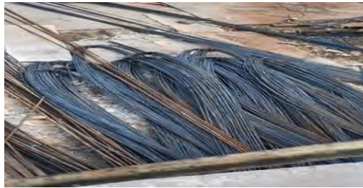
Gambar 2. 2 Besi Tulangan (Dokumentasi Proyek 2024)
