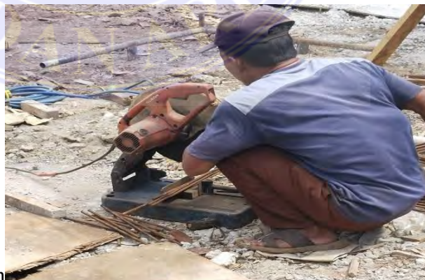
Gambar 4. 2 Pemotongan besi (Dokumentasi Proyek 2024)
