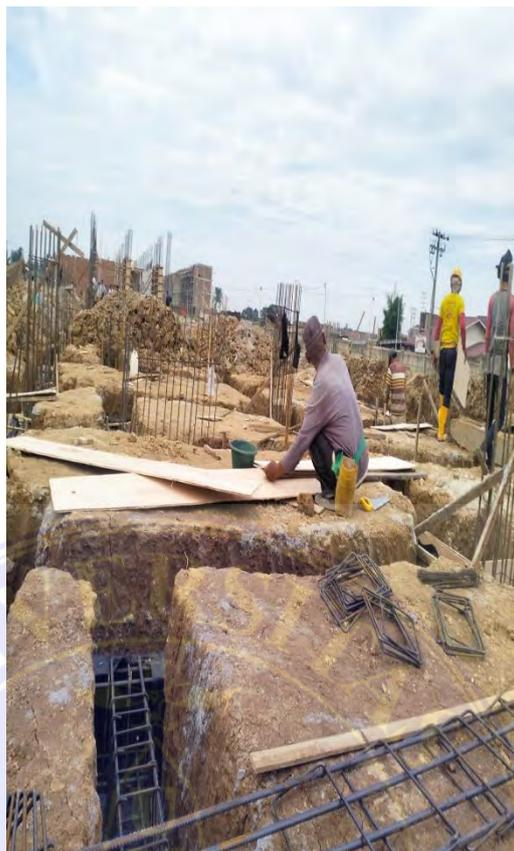
Gambar 3.1.4 Pemasangan Kayu Bekisting
