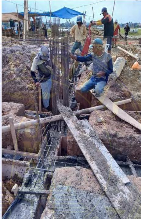
Gambar 3.1.3 Pekerjaan Pengecoran Pondasi
