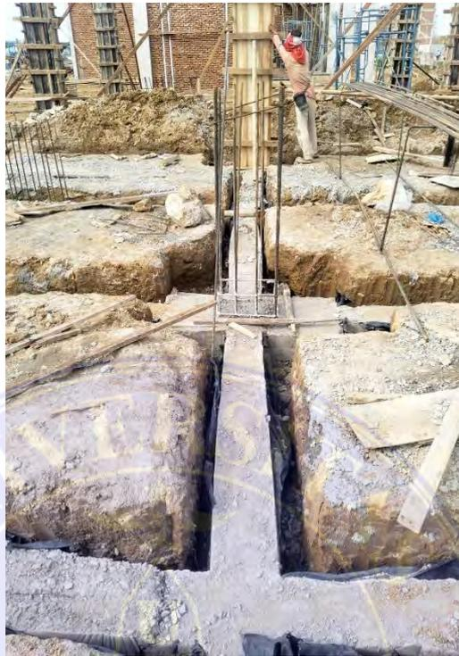
Gambar 3.1.6 Hasil Setelah Pembongkaran Bekisting
