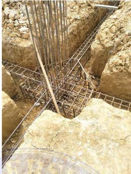
Gambar 3.1.3 Pekerjaan Peletakkan Balok Sloff
