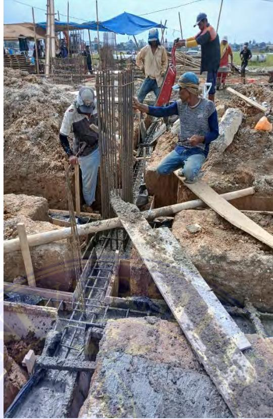
Gambar 3.1.5 Pengecoran Pondasi
