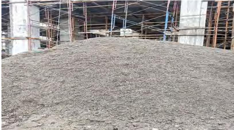
*Gambar 3 10 Pasir beton*
