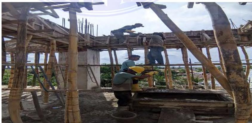
*Gambar 4. 6 pengecoran balok anak*
