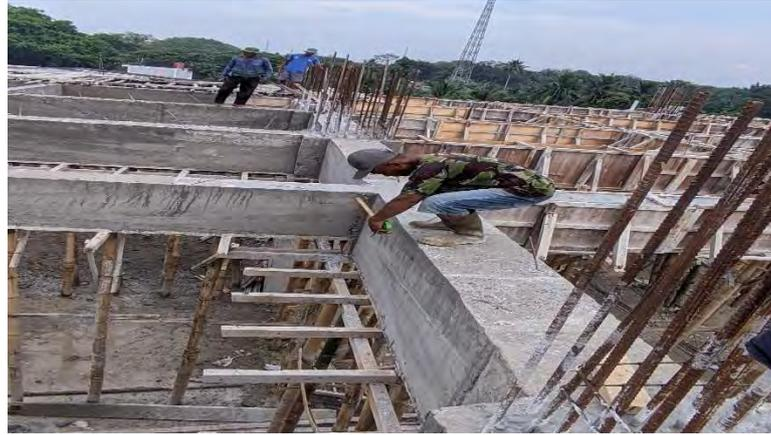
*Gambar 4. 8 Pengecekan kembali balok setelah pelapasan bekisting*
