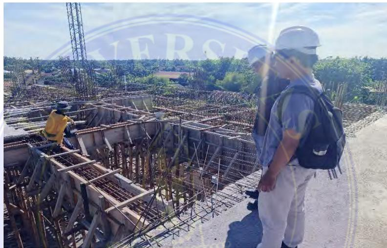
Gambar 3 13 Pemasangan bekisting
