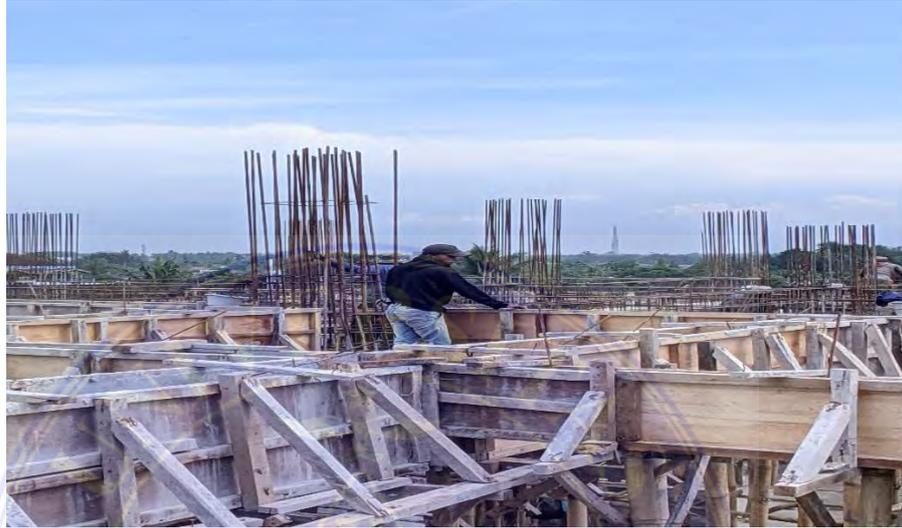
*Gambar 4. 5 pemasangan bekisting*
