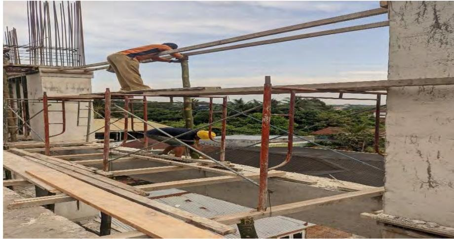
*Gambar 4. 3 persiapan pekerjaan balok anak*
