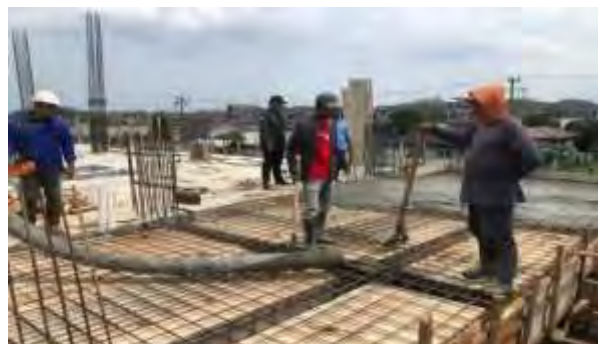
Gambar 31. Pengecoran balok (Dokumentasi proyek, 2025)
