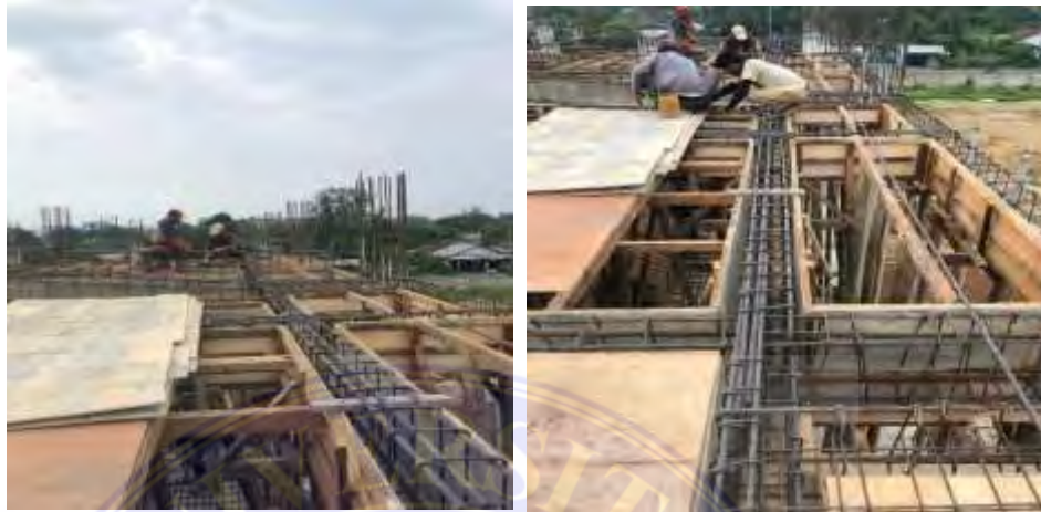
Gambar 30. Penulangan balok (Dokumentasi proyek, 2025)
