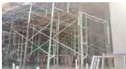
Gambar 18. Scalfolding (Dokumentasi Proyek, 2025)
