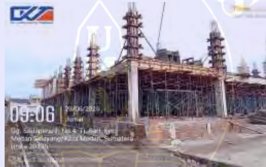
Gambar 32. Pelepasan bekisting (Dokumentasi Proyek, 2025)
