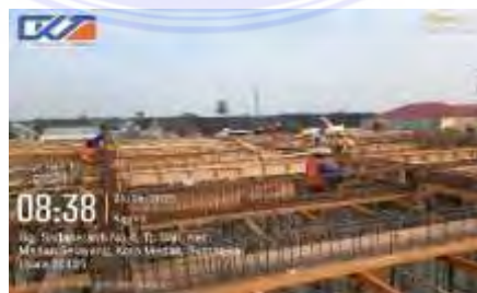
Gambar 14. Bekisting (Dokumentasi Proyek, 2025)
