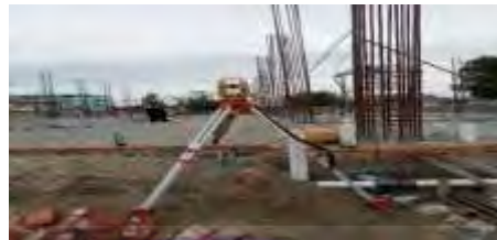
Gambar 8. Theodolit (Dokumentasi Proyek, 2025)
