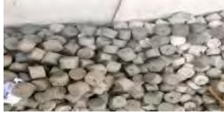
Gambar 25. Selimut beton (Dokumentasi Proyek, 2025)
