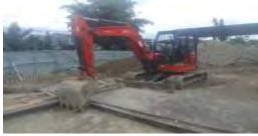
Gambar 4 Excavator (Dokumentasi Proyek, 2025)
