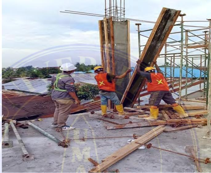
Gambar 33: pada saat pembukaan bekisting
