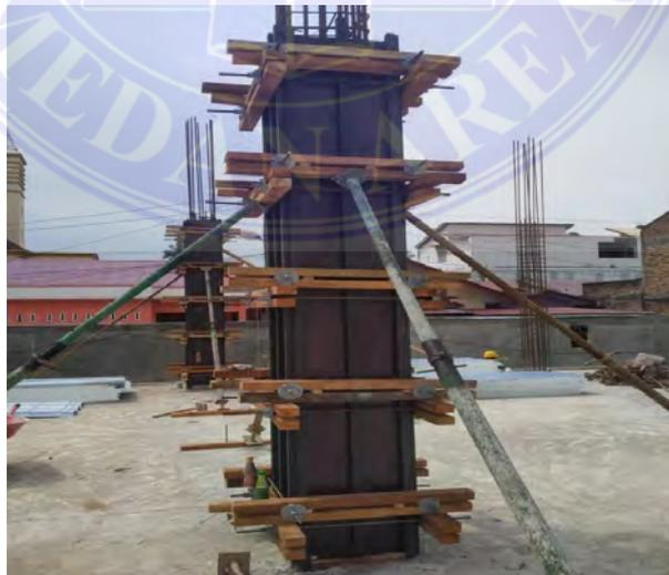
Gambar 30: Pemasangan Bekisting Kolom (Dokumentasi Proyek)
