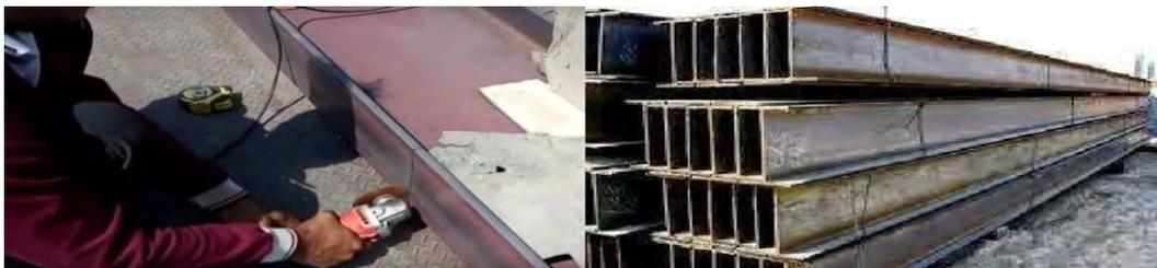
gambar 3 2 Pemotongan baja (Dokumentasi proyek, 2025)
