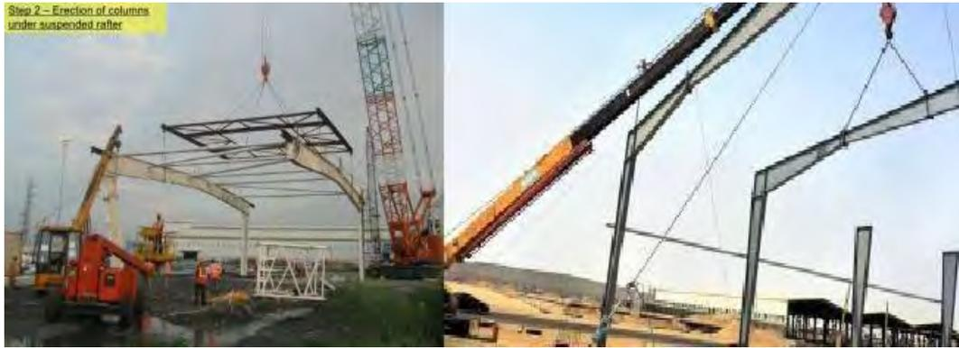
gambar 3 5 Proses pengangkatan kontruksi baja (Dokumentasi proyek, 2025)
