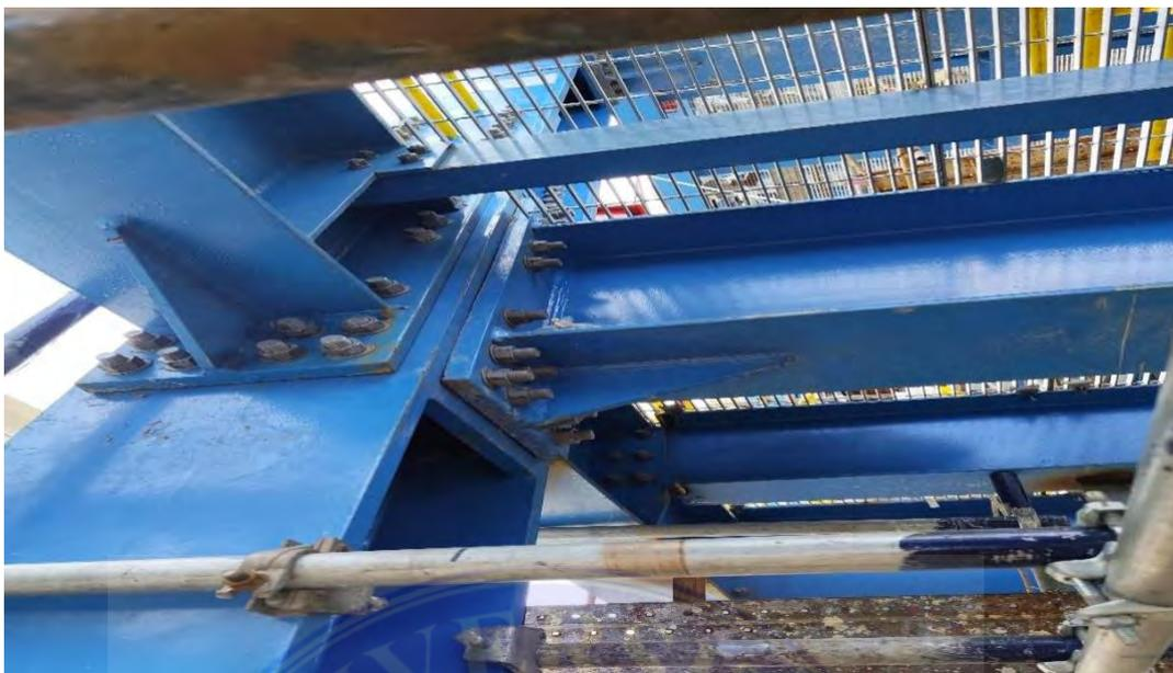
Gambar sambungan balok baja
