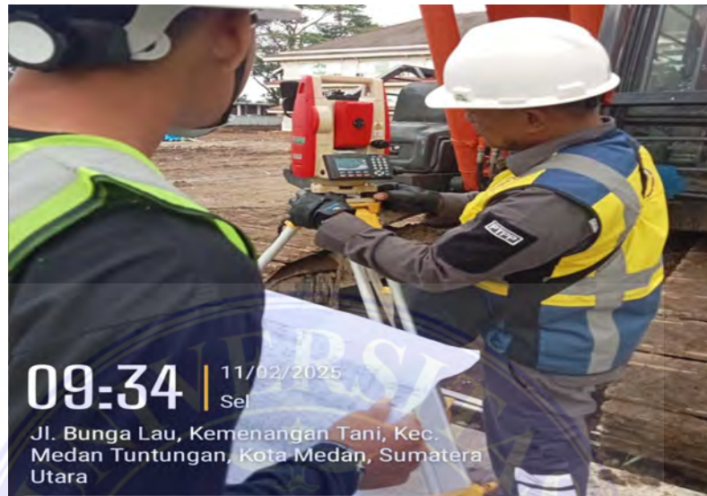
Gambar 20 Penentuan Titik Bor (Dokumentasi,2025)
