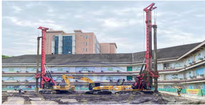
Gambar 3 Bor Pile (Dokumentasi,2025)
