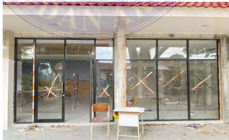
Gambar 18 pembuatan kantor lapangan (Dokumentasi,2025)
