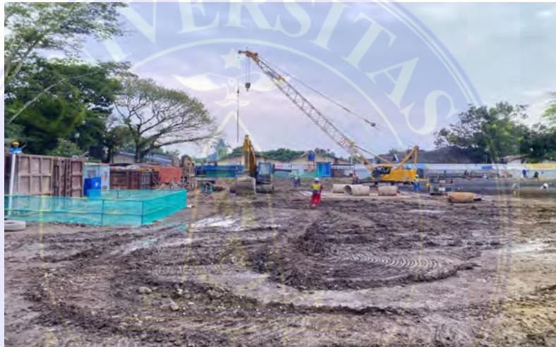
Gambar 16 Pembuatan Akses Jalan Kerja (Dokumentasi,2025)
