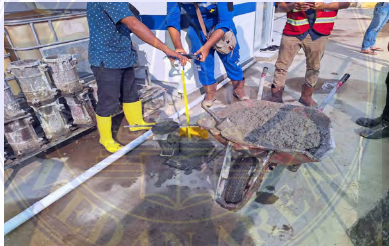
Gambar 11 Beton ready mix (Dokumentasi,2025)
