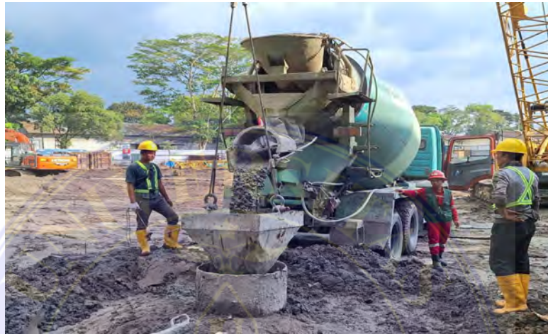
Gambar 26 pengecoran titik bor pile (Dokumentasi,2025)
