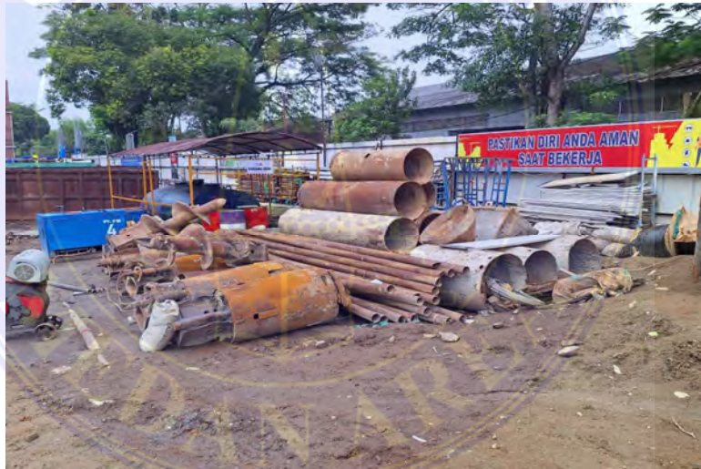
Gambar 17 peralatan dan perlengkapan proyek (Dokumentasi,2025)
