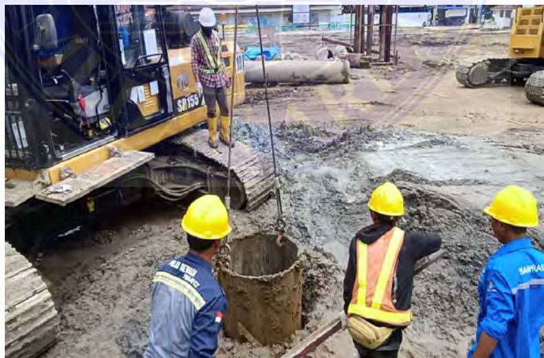
Gambar 23 pemasangan casing (Dokumnetasi,2025)
