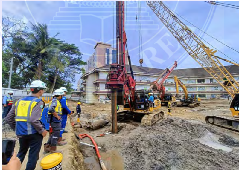
Gambar 21 Pengeboran Titik Bor Pile (Dokumentasi,2025)
