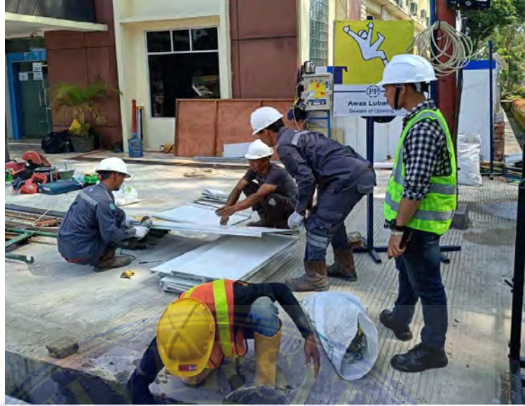
Gambar 19 pembuatan pagar proyek (Dokumentasi,2025)
