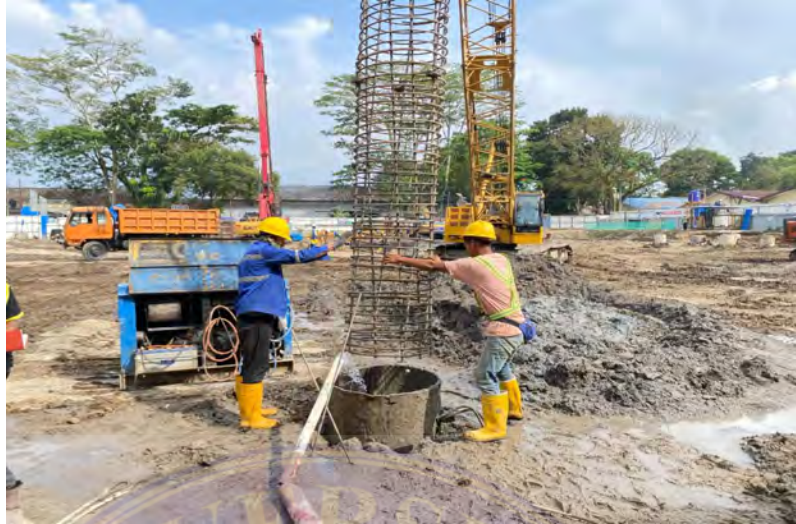
Gambar 25 pemasangan tulangan (Dokumentasi,2025)
