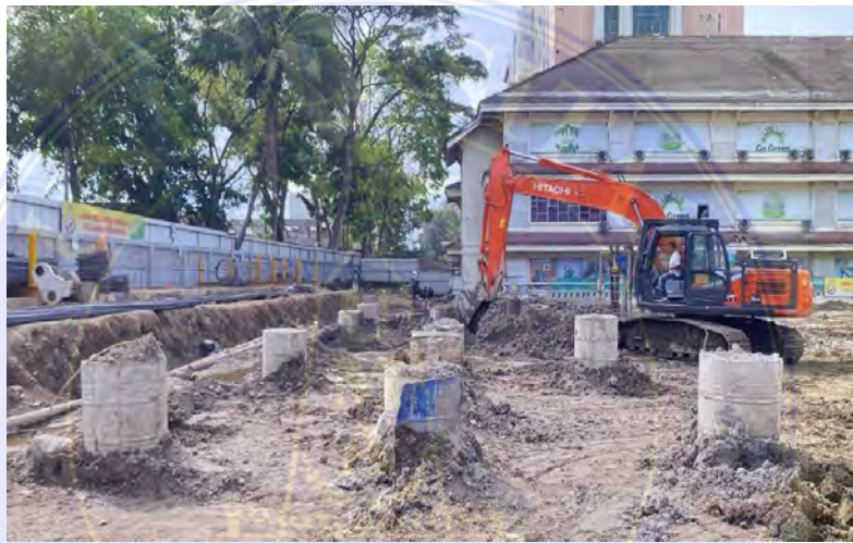
Gambar 27 ujung coran bor pile di lapisi drum bekas (Dokumentasi,2025)
