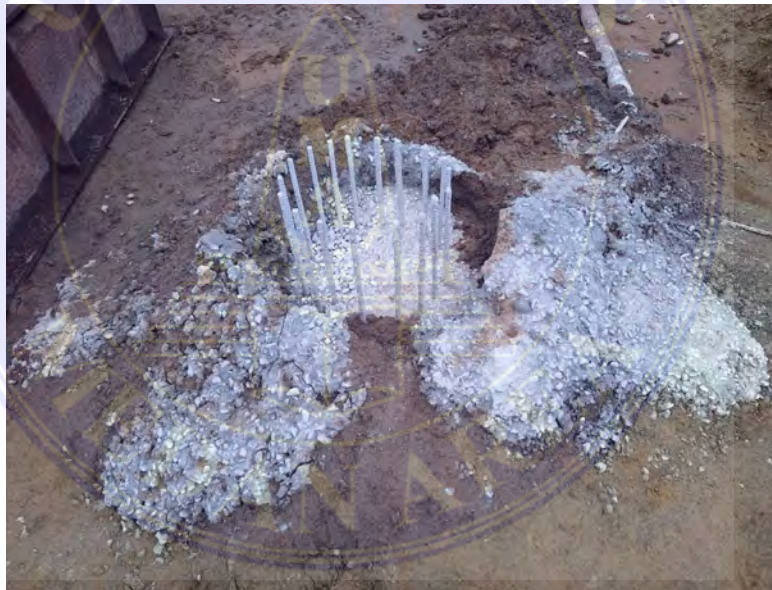
Gambar 28 pemeriksaan visual kepala pile (Dokumentasi,2025)
