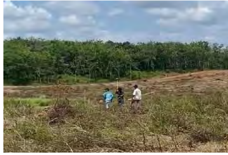
Gambar 7. Pemasangan Pancang Isi
