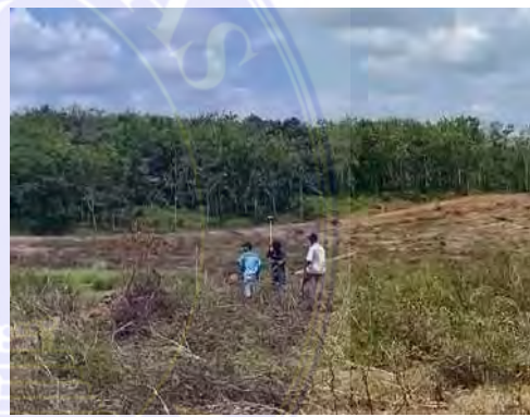
Melakukan Pemasangan Pancang Isi
