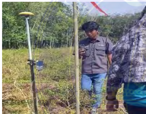
Melakukan Pemasangan Pancang Rumpuan
