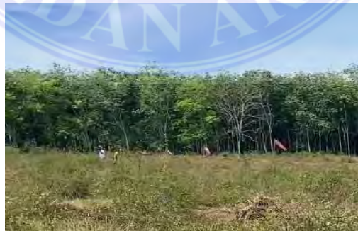
Gambar 5. Pemasangan Pancang Kepala
