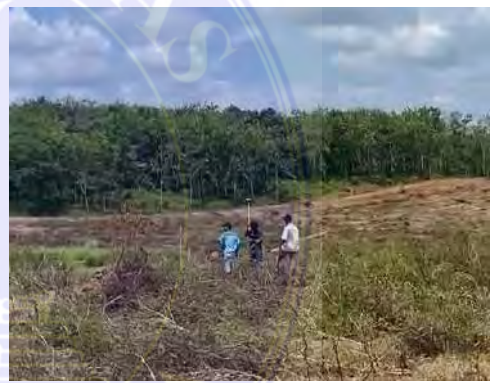
Melakukan Pemasangan Pancang Isi
