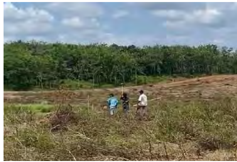
Gambar 7. Pemasangan Pancang Isi
