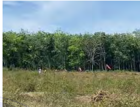
Melakukan Pemasangan Pancang Kepala
