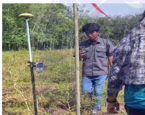
Melakukan Pemasangan Pancang Rumpuan
