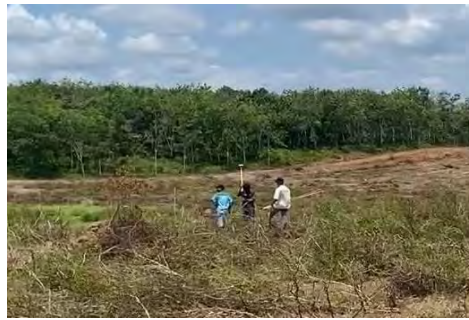
Gambar 7. Pemasangan Pancang Isi
