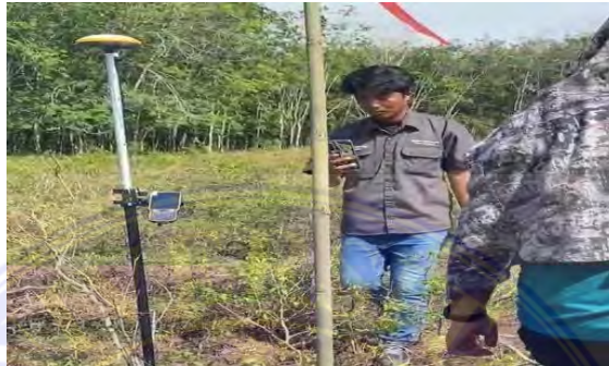
Gambar 6. Pemasangan Pancang Rumpukan
