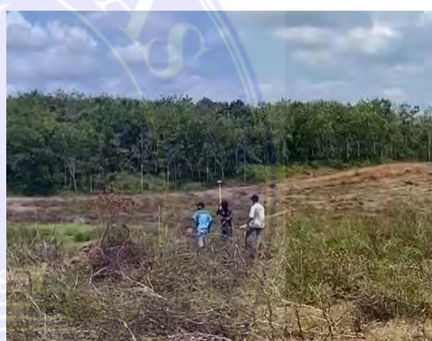
Melakukan Pemasangan Pancang Isi
