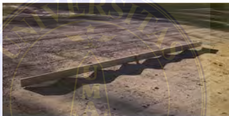
Gambar 5. Retak Keriting ( Corrugation Cracking ).
