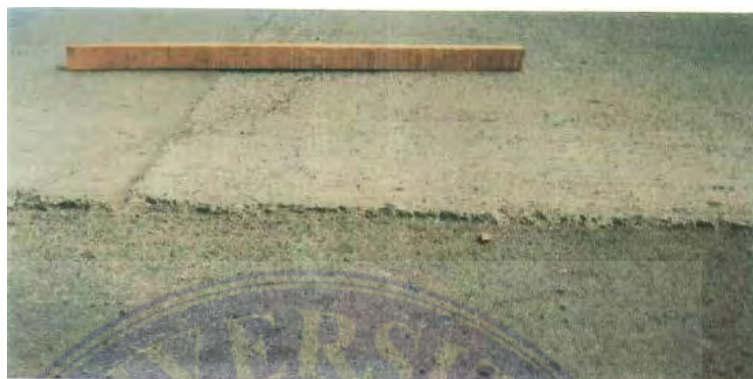
Gambar 7. Retak Sambung ( Joint Reflection Crackingi ) (Manual pemeliharaan jalan No: 03/MN/B/2011)
