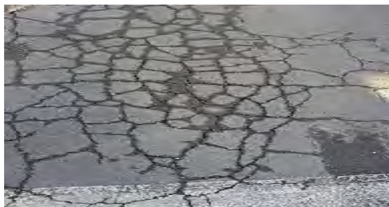
Gambar 4. Retak Kulit Buaya ( Alligator Cracking )
