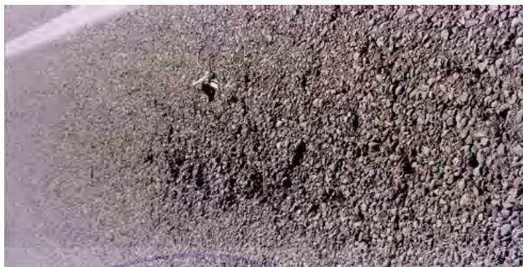
Gambar 10. Pelepasan Butir ( Weathering/Raveling ) (Manual pemeliharaan jalan No: 03/MN/B/2011)
