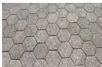
Gambar 2. 4 Paving Block Bentuk Segi Banyak
