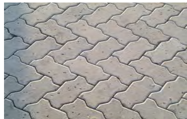
Gambar 2. 4 Paving Block Bentuk Segi Banyak
