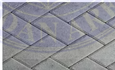
Gambar 2. 3 Paving Block Bentuk Segi Empat
