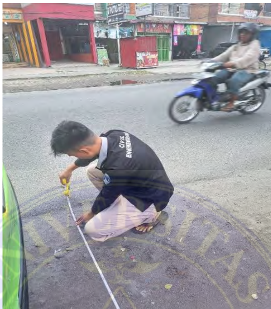
Dokumentasi Pengukuran Bahu Jalan
