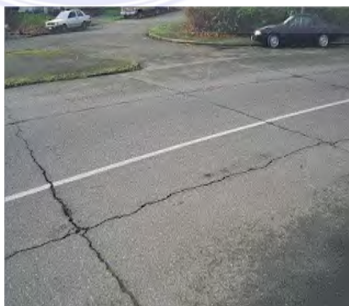
Gambar 9 Retak sambungan Jalan (Shahin, 1994)
