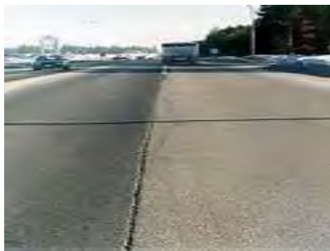
Gambar 10 Retak Sambungan pelebaran jalan (Shahin, 1994)
