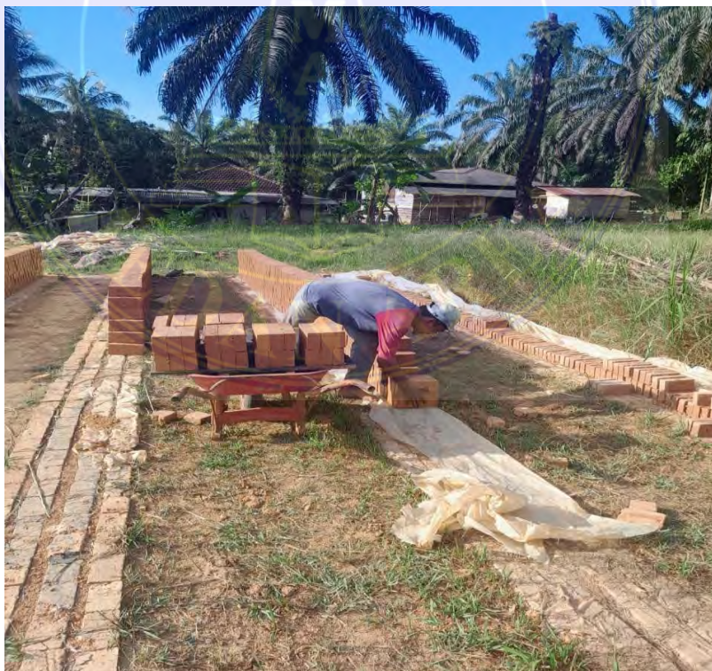
Lampiran 4 Penyusunan Batu Bata
