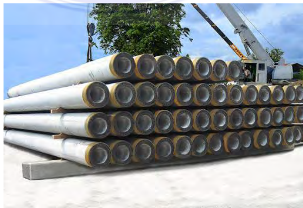
Gambar 18. Tiang Pancang Beton (Buku Perencanaan Jembatan PUPR,2022)
