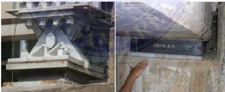
Gambar 12. Landasan Jembatan (Buku Perencanaan Jembatan PUPR,2022)
