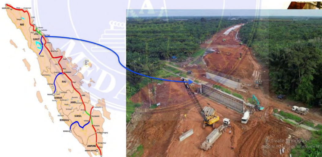
Gambar 19. Lokasi Jembatan Irigasi Bajayu tol Tebing Tinggi-Inderapura (Data Proyek, 2025)
