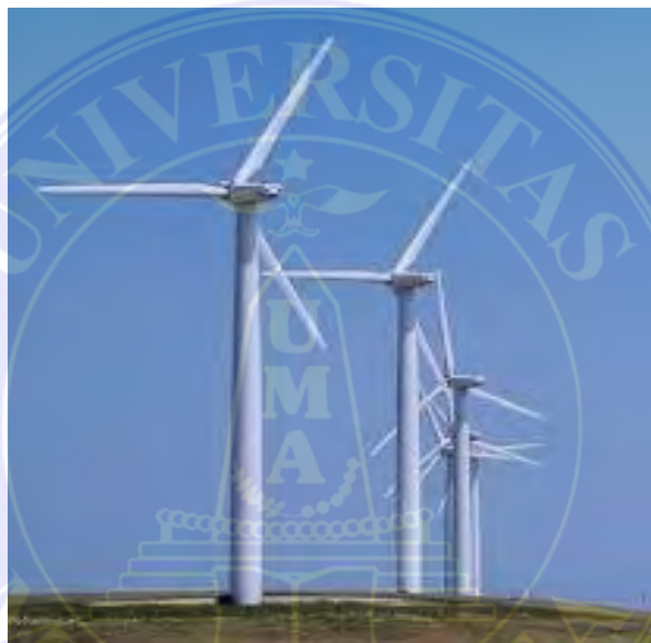
Gambar 2. 2. Jenis turbin angin sumbu horizontal
