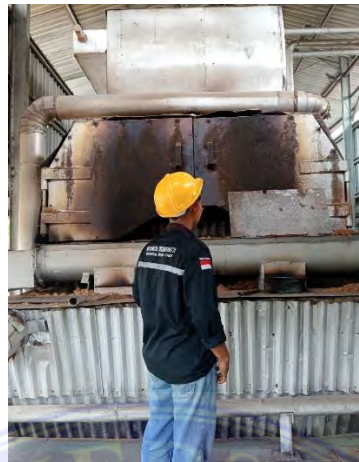
Lampiran 1. Dokumentasi di Boiler
