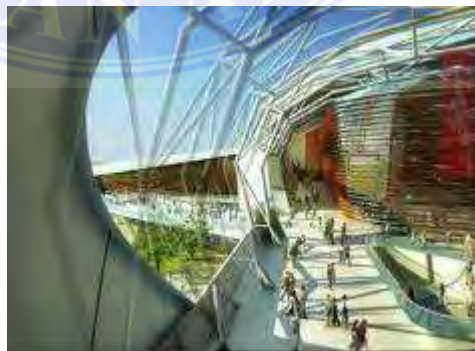
Gambar 2. 48 Struktur Pipa dan Kabel Baja pada Yongjia Gymnasium
