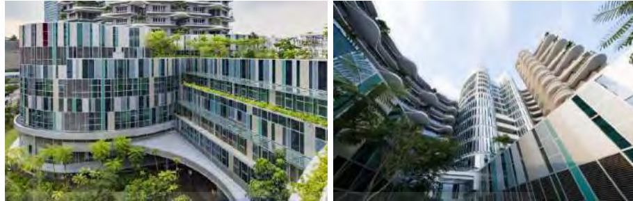
Gambar 2.4.2. 13 Detail fasad dengan kaca mozaik
