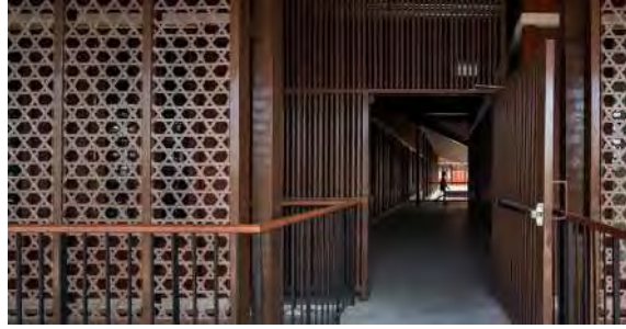
Gambar 2.4.2. 28 Detail Penggunaan Material Kayu pada Pintu
