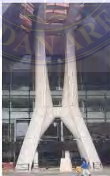
Gambar 2. 33 Kolom Teater Jakarta
