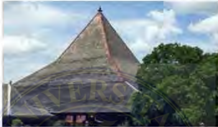
Gambar 2. 11 Bentuk Atap Bangunan Pendopo
