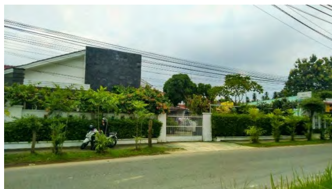
Gambar III.10 Foto Bangunan Disebelah Utara Site
