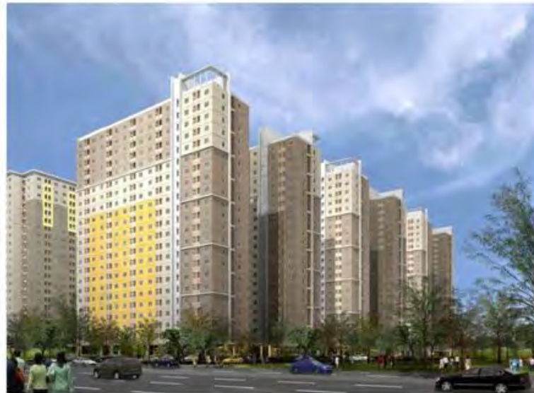
Gambar II.22 Fasad Rusunami Kalibata, Jakarta
