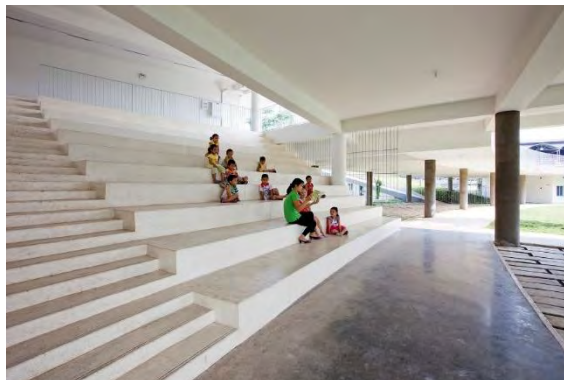
Gambar II.17 Material Ubin pada Lantai Farming Kindergarten
