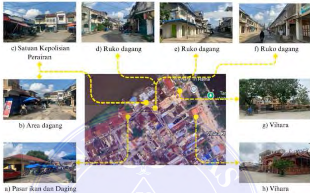
Gambar 3. 9 Eksisting bagian Timur
