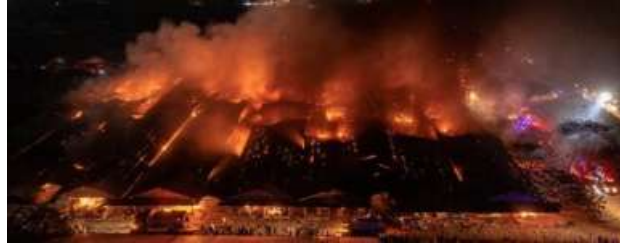
Gambar 2. 31 Pasar Johar kebakaran pada 9 mei 2015
