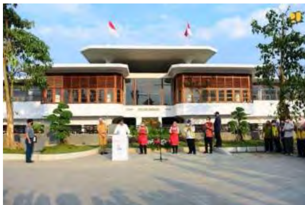
Gambar 2. 33 Bangunan Pasar Johar setelah revitalisasi
