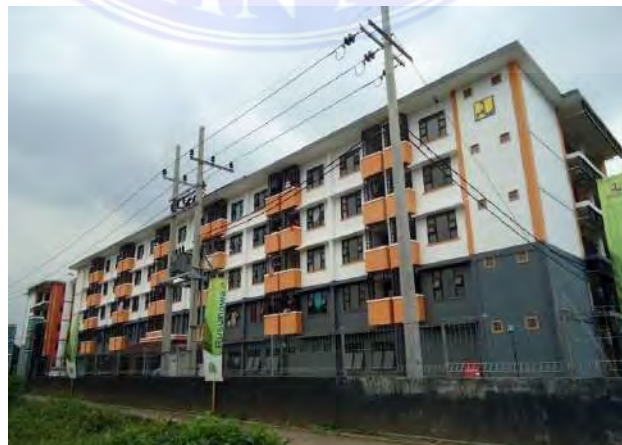
Gambar 2. 18 Bangunan Rusunawa Buring 1
