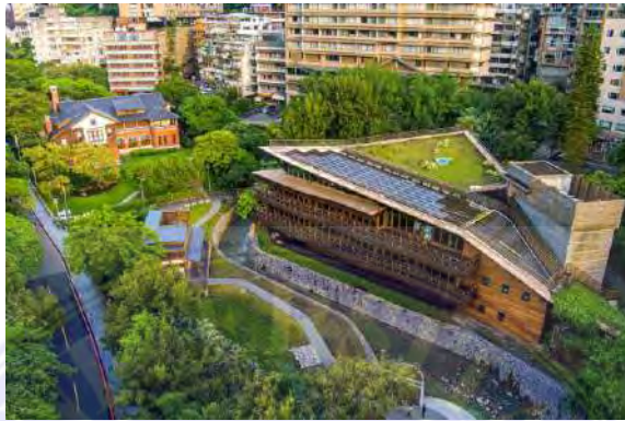
Gambar 2.38 Atap green roof dan panel surya pada Beitou Public Library
