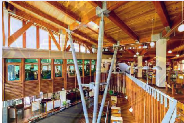
Gambar 2.37 Penggunaan kayu daur ulang pada struktur Beitou Public Library
