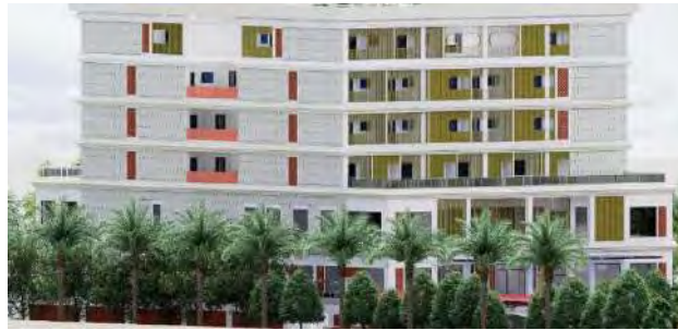
Gambar 5. 8 Fasad di sisi barat dan utara.
