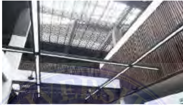
Gambar 2 32 Kisi-Kisi Kayu untuk Menyaring Panas dan Udara
