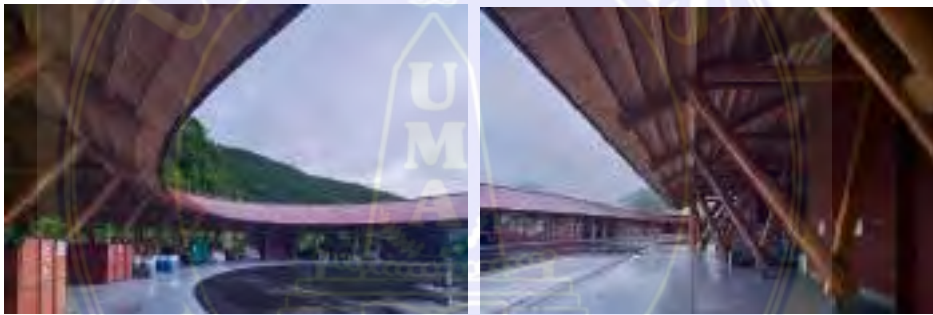
Gambar 2 44 Struktur Kaki Kolom Menggunakan Material Kayu Cedar
