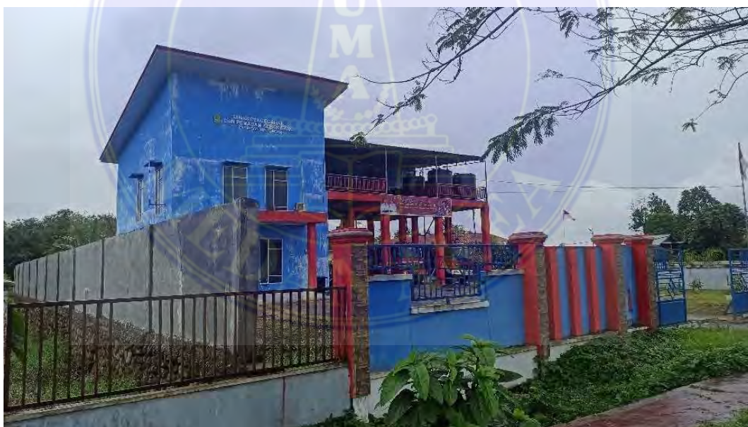
Gambar III.7. Foto sekitar site pada site alternatif 1
