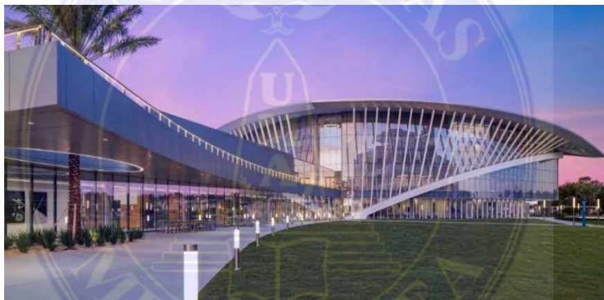
Gambar II.21 View bangunan dari RTH
