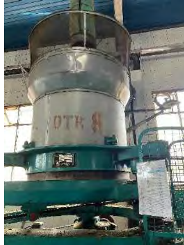
Gambar 30. Penggulungan menggunakan mesin OTR
