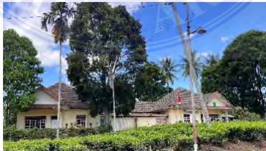
Gambar 3. Perumahan Karyawan Pimpinan Kebun Unit Bah Butong
