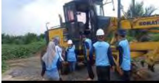
Gambar 14. Proses Pemel Jalan
