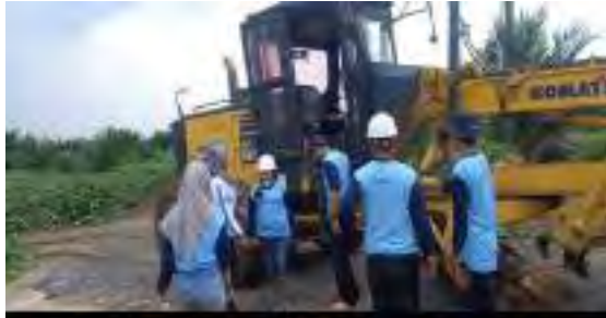
Gambar 14. Proses Pemel Jalan
