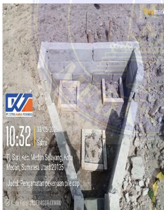
Gambar pemasangan bekisting
