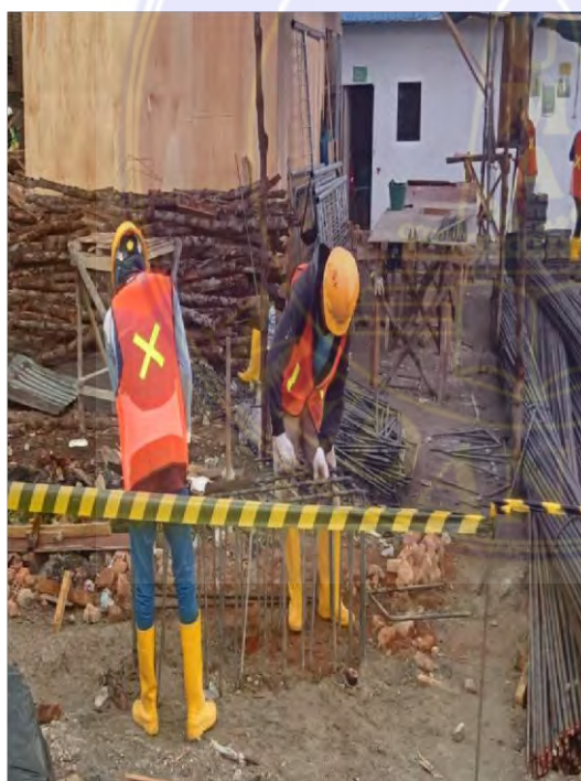
Gambar perakitan tulangan pile cap
