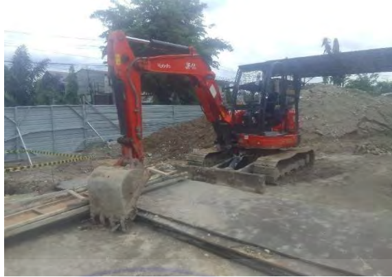
Gambar 3. 1 Excavator (Dokumentasi proyek 2025)
