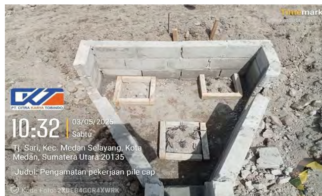
Gambar 4. 4 Pemasangan Bekisting (Dokumentasi proyek 2025)
