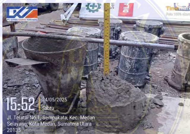
Gambar 3. 12 Slump Test (Dokumentasi proyek 2025)
