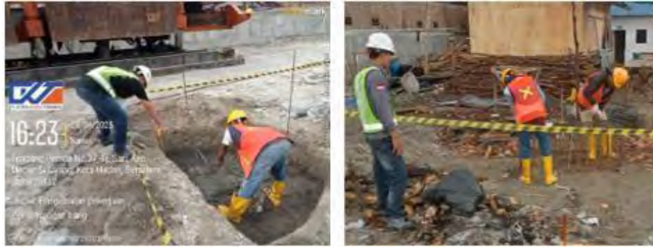
Gambar 3. 25 Pengecekan Pengerjaan Pile Cap (Dokumentasi proyek 2025)
