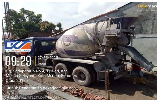
Gambar 3. 11 truck Mixer Beton (Dokumentasi proyek 2025)
