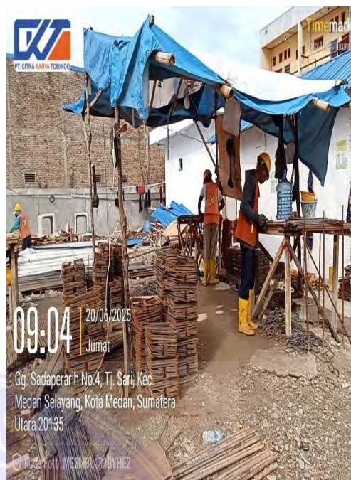
Gambar pengerjaan tulangan pile cap
