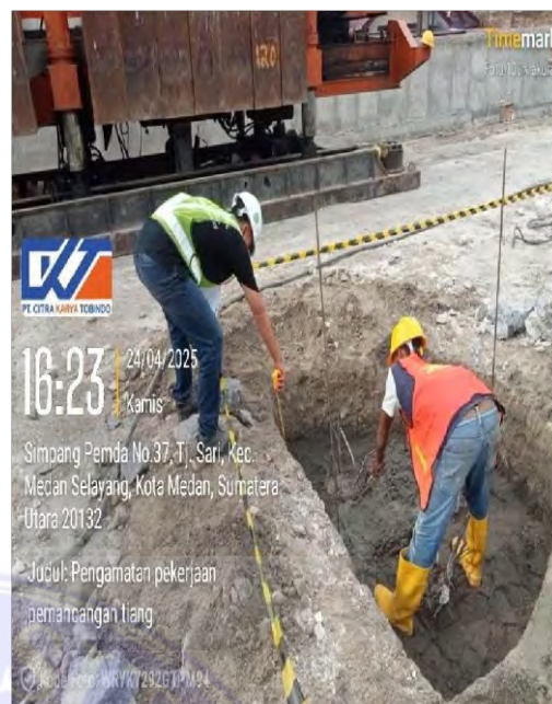
Gambar pengerjaan lantai kerja dan pasir urug
