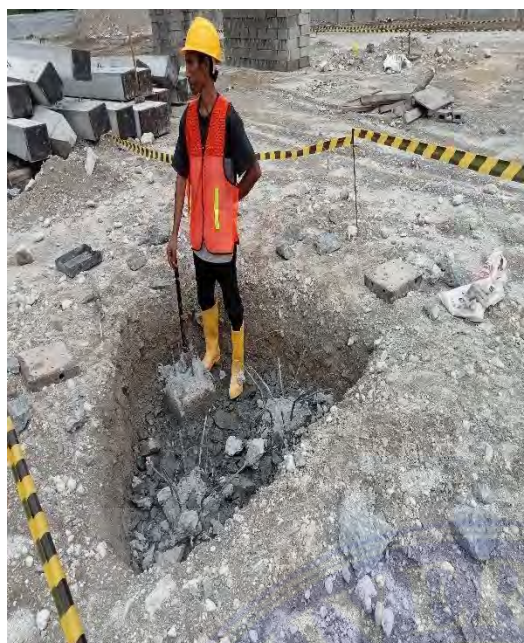
Gambar pemotongan kepala tiang pancang
