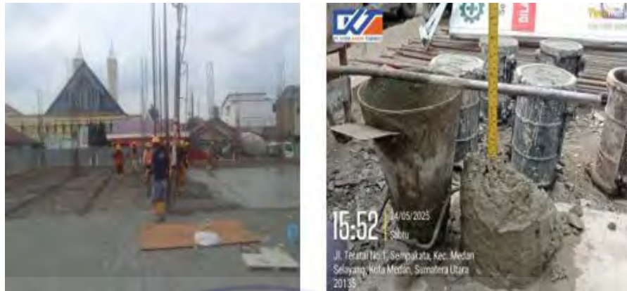
Gambar 4. 6 Pengecoran pile cap dan plat (Dokumentasi proyek 2025)
