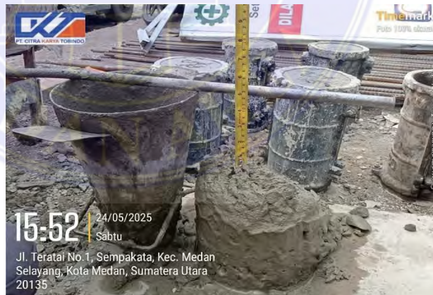
Gambar 3. 26 Uji slump (Dokumentasi proyek 2025)
