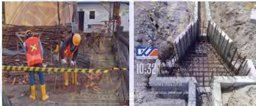
Gambar 4. 5 Perakitan Tulangan dan Pemasangan (Dokumentasi proyek 2025)
