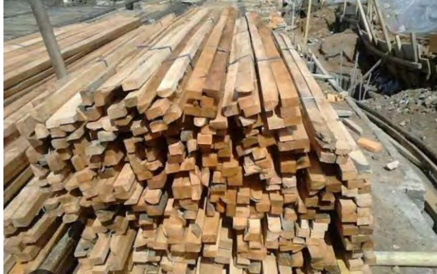
Gambar 3. 23 Kayu (Dokumentasi proyek 2025)
