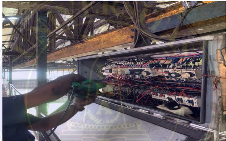
Gambar 4.5: Pembersihan Komponen
