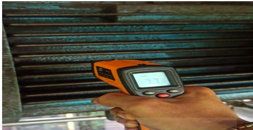
Gambar 4.3: Pengecekan Suhu Electro Motor
