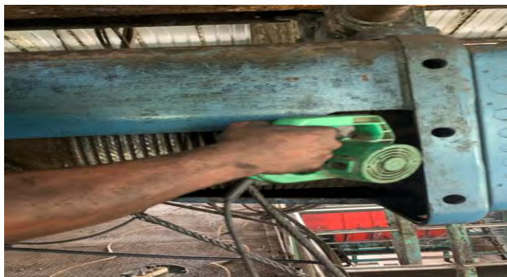
Gambar 4.7: Pembersihan Sling
