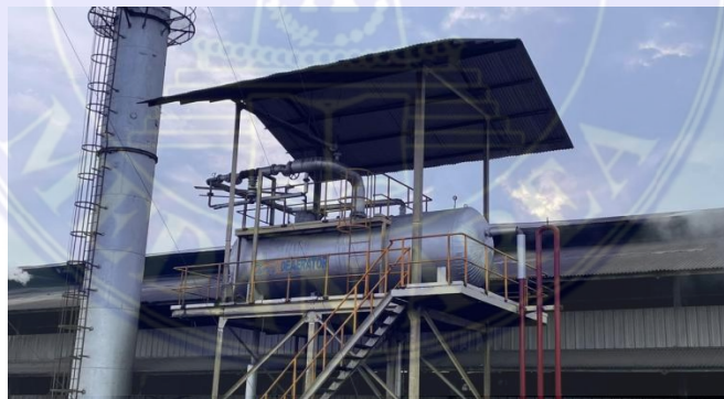
Gambar 3. 63 Thermal Deaerator
