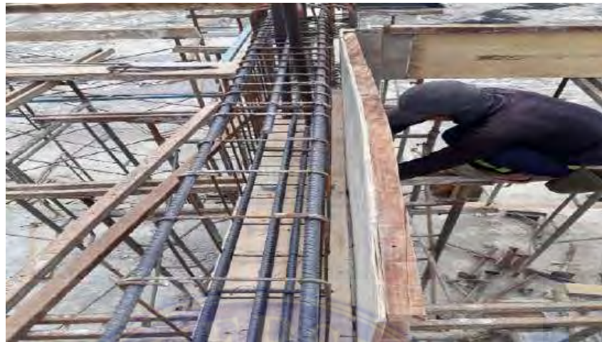
Gambar 4.3. Kondisi Bekisting Balok di Lapangan
