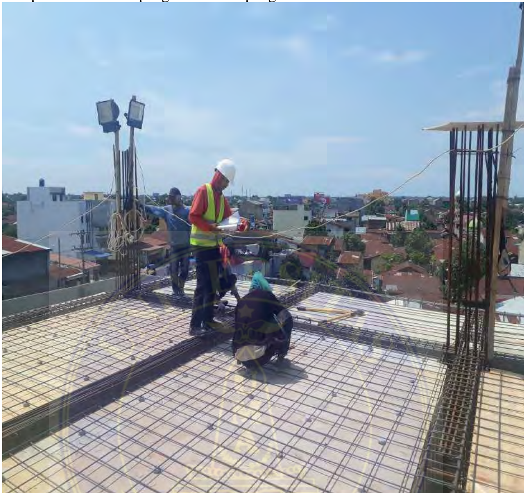
Lampiran 3. Gambar pengecekan di lapangan
