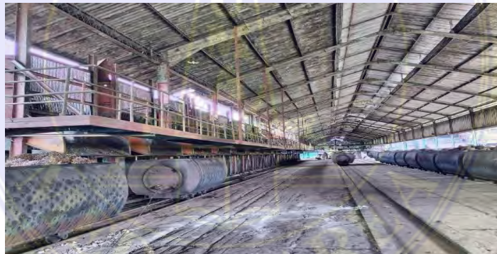
Gambar 3. 3. Stasiun Loading Ramp
