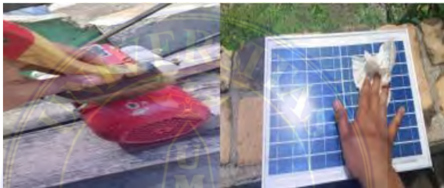
Gambar 3.1 Pembersihan Generator dan Panel Surya
