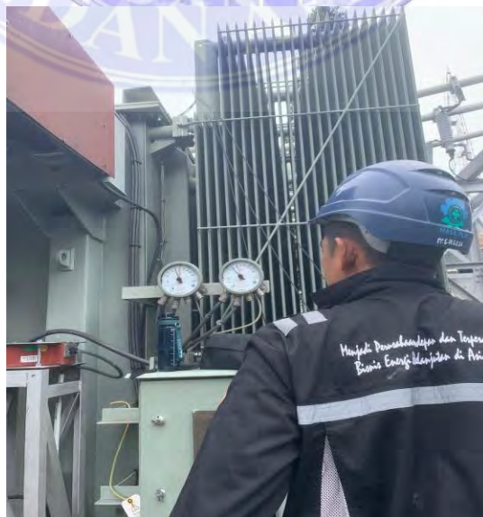
Gambar 2.2 Trafo Transmisi
