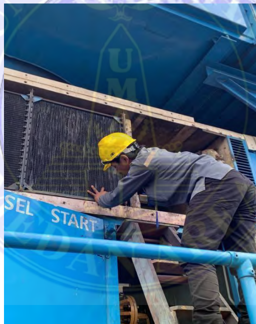
Gambar 2.4 Perbaiki radiator PLTG
