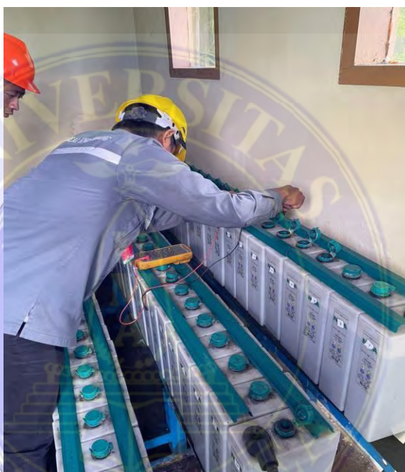
Gambar 3.5 Pengecekan Batrai
