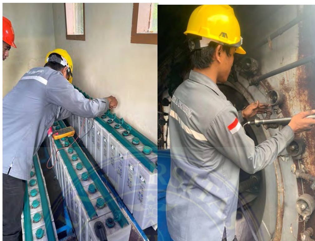
Gambar 3. Pemeliharaan batrai PLTG
