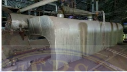
Gambar 3. 37 Bentuk Drum pada Boiler
