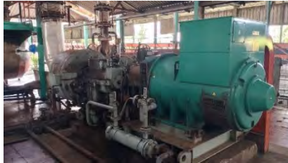
Gambar 3. 43 Bentuk Turbin Uap
