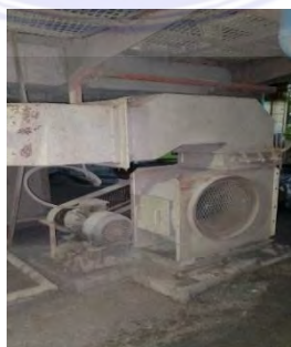
Gambar 3. 32 Bentuk Forced Draft Fan
