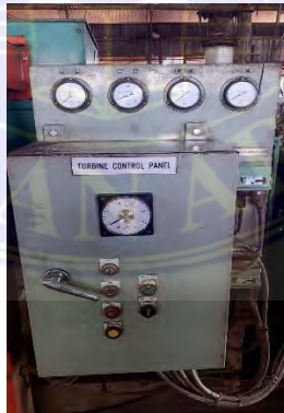
Gambar 4. 9 Bentuk Panel Kontrol Turbin
