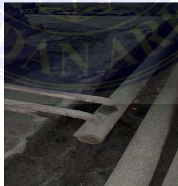
Gambar 3. 38 Bentuk Pipa Blowdown
