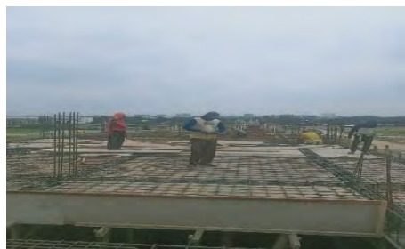
Gambar 4.6 Proses Pembesian Pelat (Dokumentasi Proyek)
