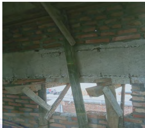
Gambar No.1 Proses Pemasangan Perancah Untuk Mendukung Pekerjaan Bekisting Pelat Lantai
