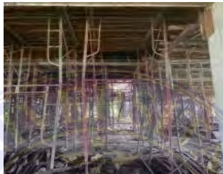
Gambar 3.22 Scaffolding (Dokumentasi Proyek)
