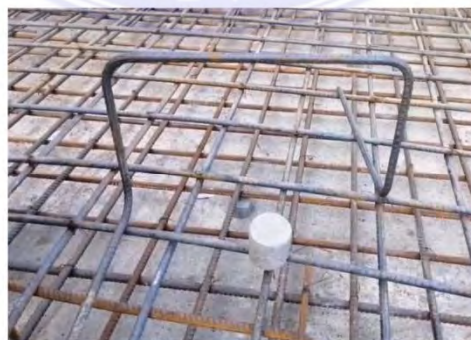
Gambar 3.39 Beton Decking (Dokumentasi Proyek)
