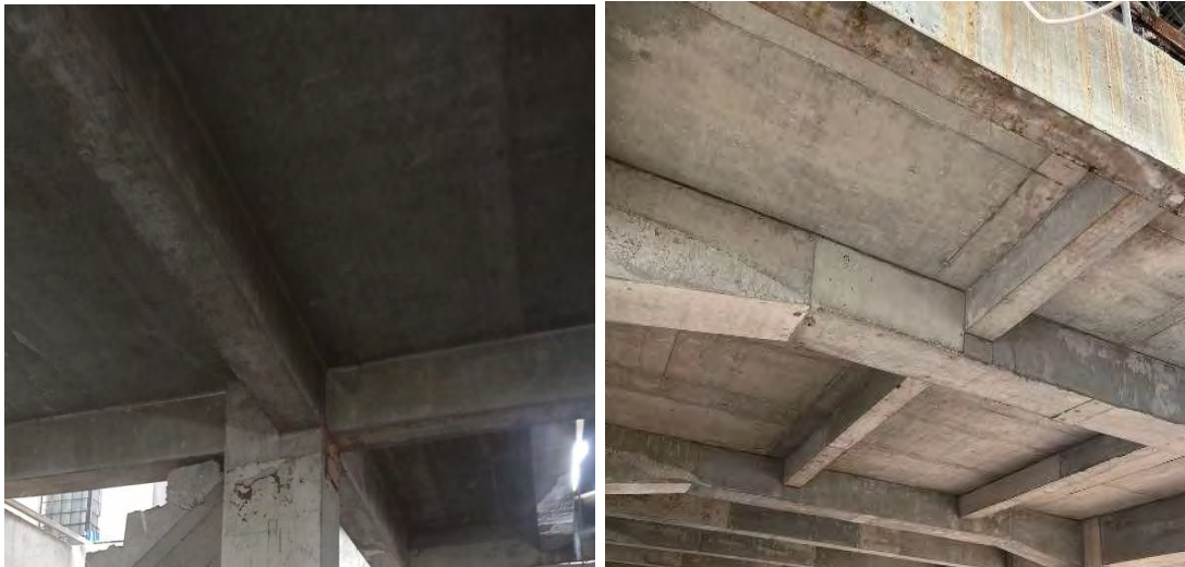
Gambar No. 7 Tampilan Pelat Lantai Setelah Pembongkaran Bekisting
