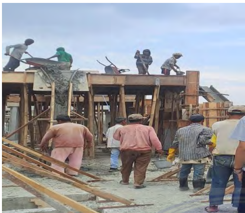
Gambar No.1 Proses Pemasangan Perancah Untuk Mendukung Pekerjaan Bekisting Pelat Lantai
