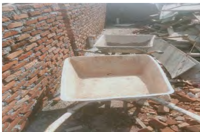
Gambar 3.13 Kereta Sorong (Dokumentasi Proyek)
