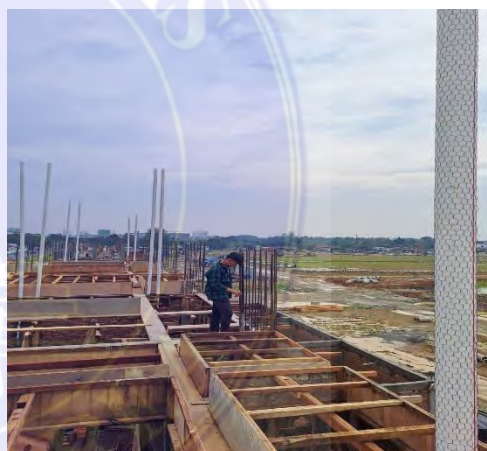
Gambar No.2 Proses Pemasangan Bekisting Kayu / Triplek Untuk Mendukung Pekerjaan Bekisting Pelat Lantai
