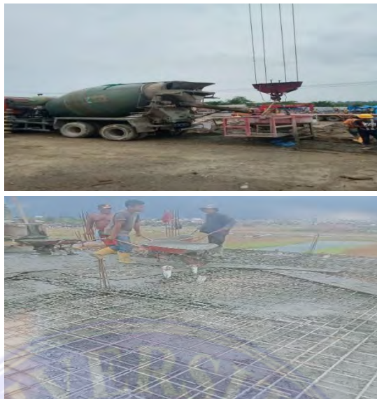
Gambar 4.7 Proses Pengecoran Pelat (Dokumentasi Proyek)
