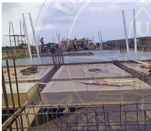
Gambar No.2 Proses Pemasangan Bekisting Kayu / Triplek Untuk Mendukung Pekerjaan Bekisting Pelat Lantai
