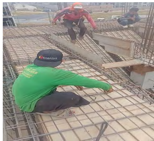
Gambar No.3 Proses Pemasangan Besi Ulir Diameter 13 Untuk Pelat 2 Arah (Horizontal dan Vertikal)
