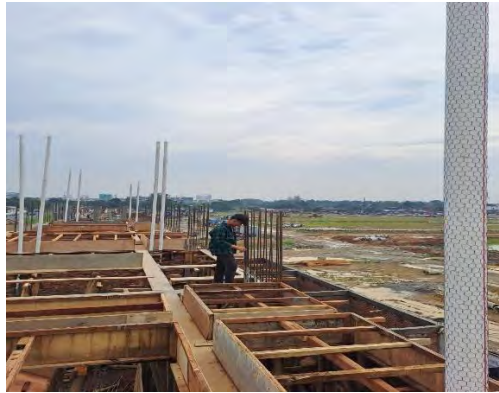
Gambar 3.9 Bekisting (Dokumentasi Proyek)
