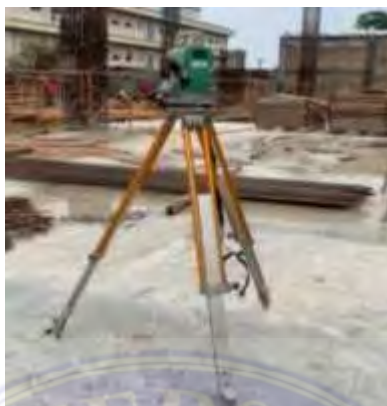
Gambar 3.7 Theodolite (Dokumentasi Proyek)
