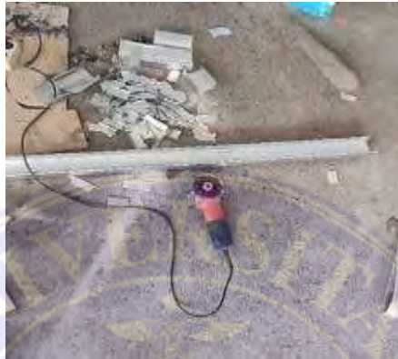
Gambar 3.24 Gerinda Tangan (Dokumentasi Proyek)
