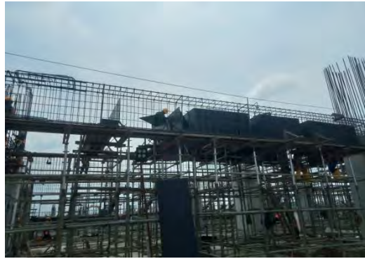
Gambar 4.4 Pemasangan Tapak Pelat (Dokumentasi Proyek)
