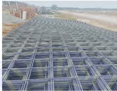
Gambar 3.33 Besi Tulangan (Dokumentasi Proyek)
