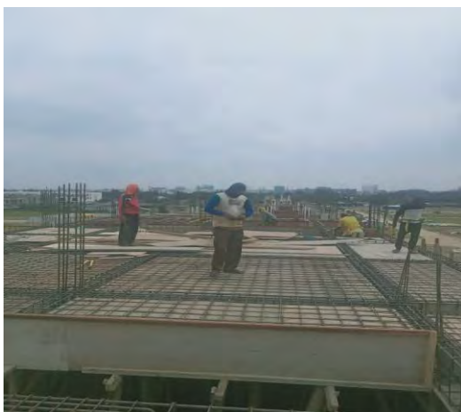
Gambar No.3 Proses Pemasangan Besi Ulir Diameter 13 Untuk Pelat 2 Arah (Horizontal dan Vertikal)
