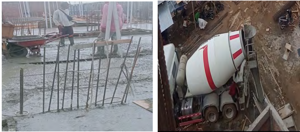
Gambar No.4 Proses pengecoran beton ready mix dengan Ketebalan coran: 14 cm.
