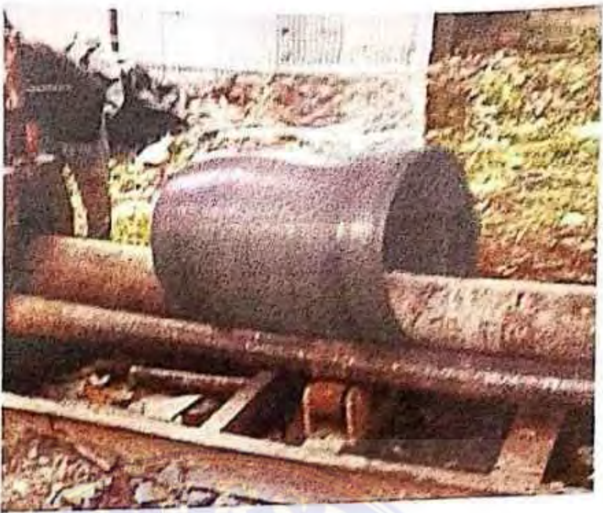
Gambar 3.13. Pengerollan Material Untuk Tangki.
