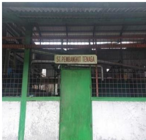
Gambar 3. 74 Stasiun Pembangkit Tenaga
