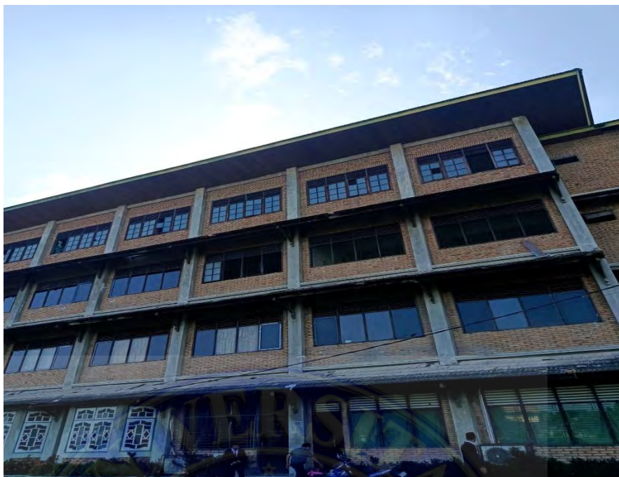
Gedung Asrama Ponpes Nurul Hakim Tembung
