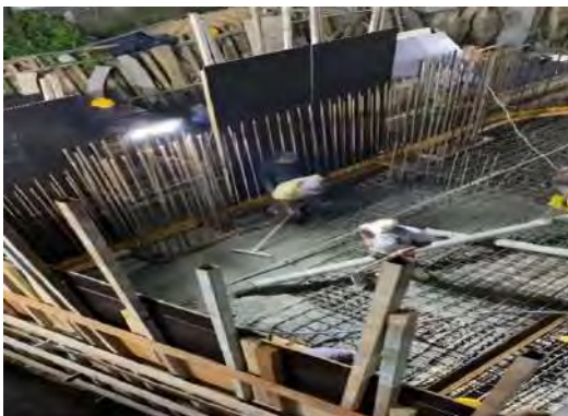
Gambar 3.33 Perataan dan Finishing Pengecoran (Dokumentasi Proyek, 2025)
