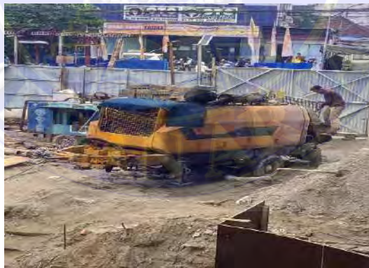
Gambar 3.10 Concrete Pump (Dokumentasi Proyek, 2025)
