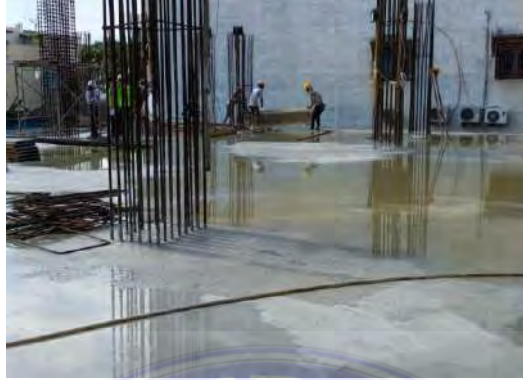
Gambar 3.33 Pekerjaan Curing Beton (Dokumentasi Proyek, 2025)
