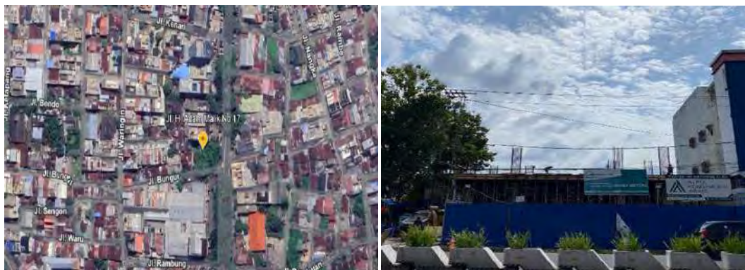
Gambar 2.1 Lokasi Proyek (Dokumentasi Proyek, 2025)
