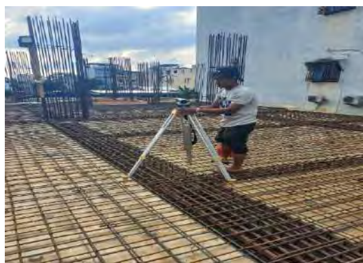
Gambar 3.23 Theodolit (Dokumentasi Proyek, 2025)
