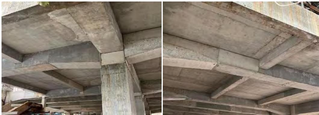
Gambar No. 7 Tampilan Pelat Lantai Setelah Pembongkaran Bekisting
