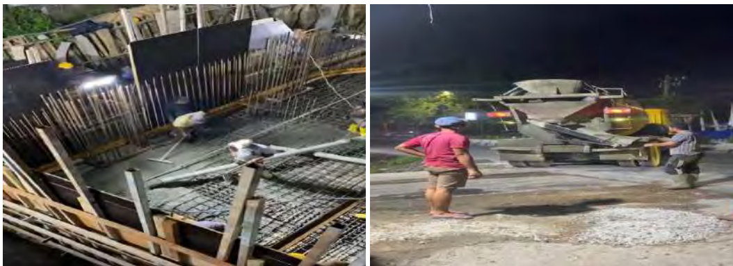
Gambar No.4 Proses pengecoran beton ready mix menggunakan concrete pump dan pipa cor. Ketebalan coran: 15 cm.
