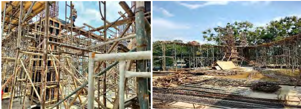
Gambar No.1 Proses Pemasangan Perancah Untuk Mendukung Pekerjaan Bekisting Pelat Lantai
