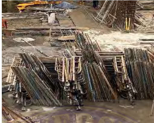
Gambar 3.14 Perancah/Scaffolding (Dokumentasi Proyek, 2025)
