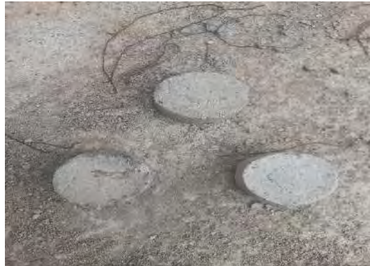
Gambar 3.21 Beton Decking (Dokumentasi Proyek, 2025)
