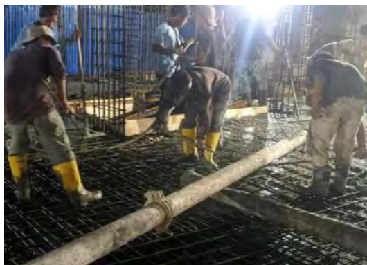
Gambar 3.30 pemasangan pipa cor (Dokumentasi Proyek, 2025)
