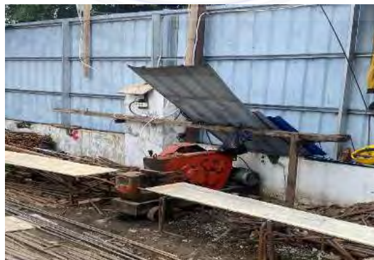
Gambar 3.12 Bar Bender (Dokumentasi Proyek, 2025)
