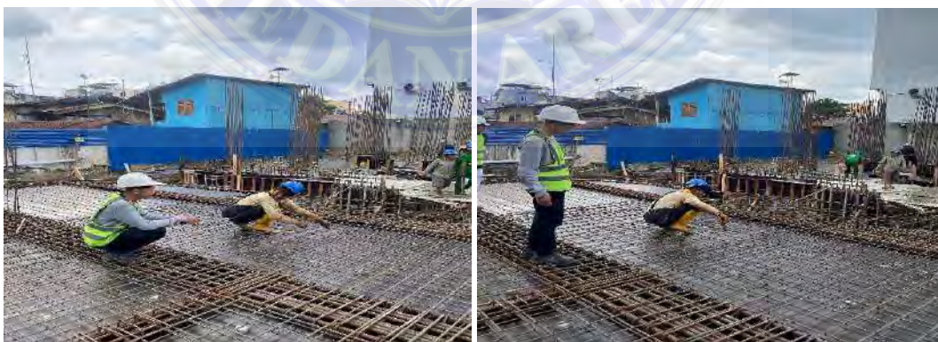
Gambar 3.27 Pemasangan tulangan (Dokumentasi Proyek, 2025)
