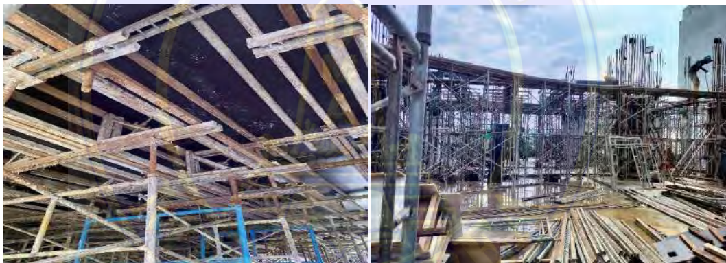
Gambar 3.25 Pemasangan scaffolding (Dokumentasi Proyek, 2025)
