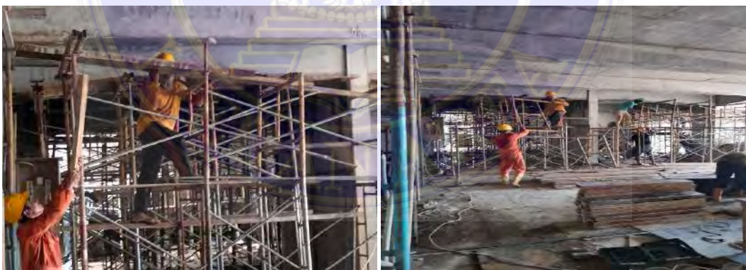
Gambar No.6 Proses Pelepasan Scaffolding dan Bekisting Setelah Beton Mencapai Kekuatan Yang Cukup
