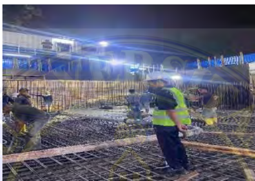
Gambar 3.31 Pekerjaan pengecoran (Dokumentasi Proyek, 2025)
