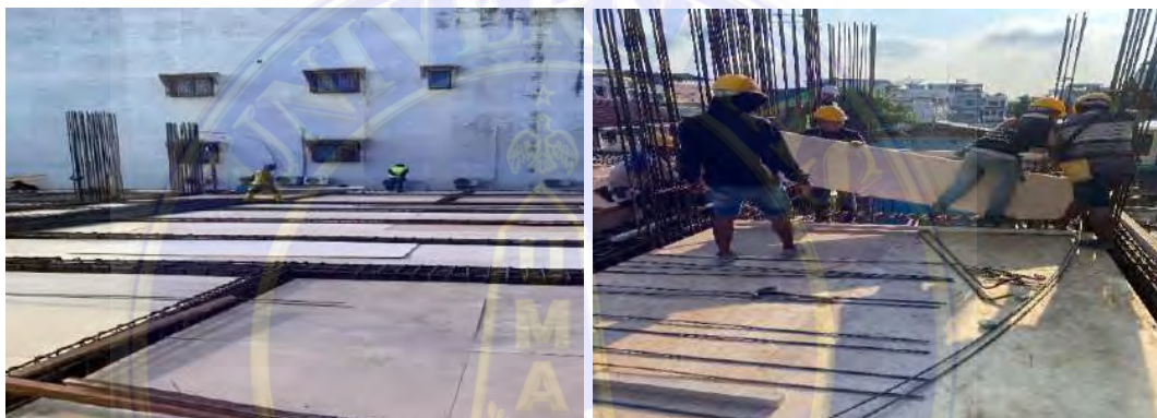
Gambar No.2 Proses Pemasangan Bekisting Kayu / Triplek Untuk Mendukung Pekerjaan Bekisting Pelat Lantai
