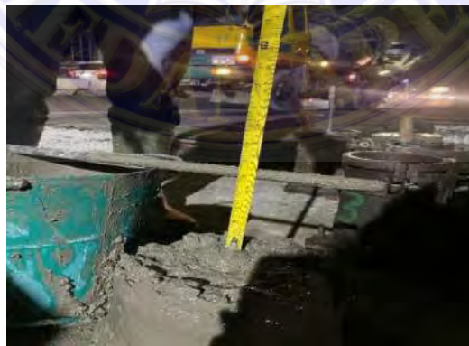
Gambar 3.29 Pengujian Slump Test (Dokumentasi Proyek, 2025)
