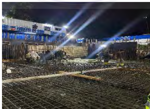
Gambar 3.24 Pipa Cor (Dokumentasi Proyek, 2025)
