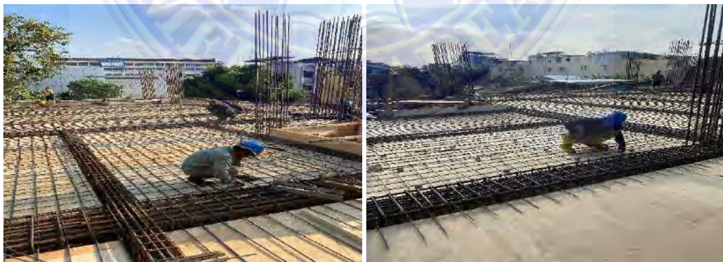
Gambar No.3 Proses Pemasangan Besi Ulir Diameter 13 Untuk Pelat 2 Arah (Horizontal dan Vertikal) Sesuai Bestek
