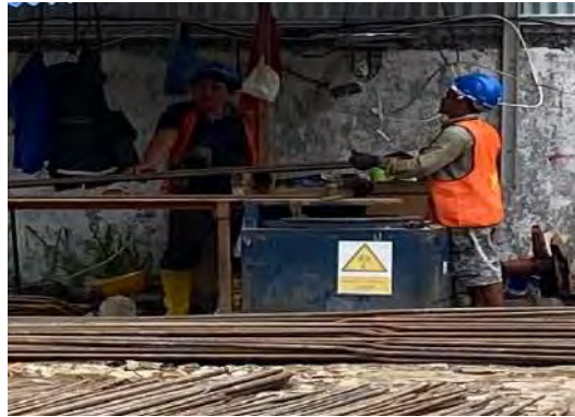
Gambar 3.13 Bar Cutter (Dokumentasi Proyek, 2025)
