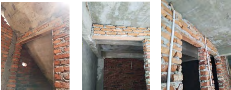
Gambar 19. Pemasangan Balok Latei Rumah Split Level
