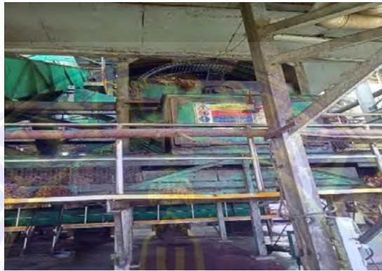
Gambar 3. 7 Stasiun Bantingan (Thresher)
